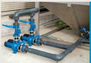
Canal de sortie d'eau
