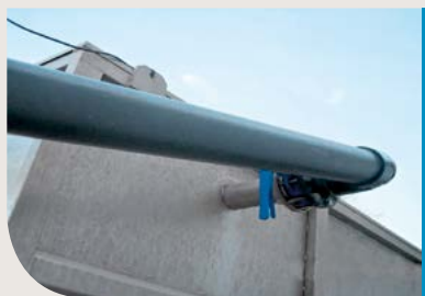
Système de retrait des boues
