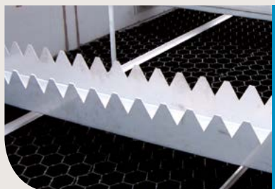
Système de recirculation / extraction des boues
